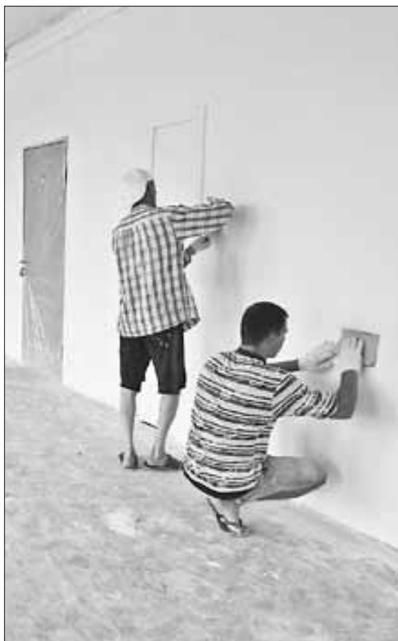
■ В 17-й школе мастера готовят стены под покраску
